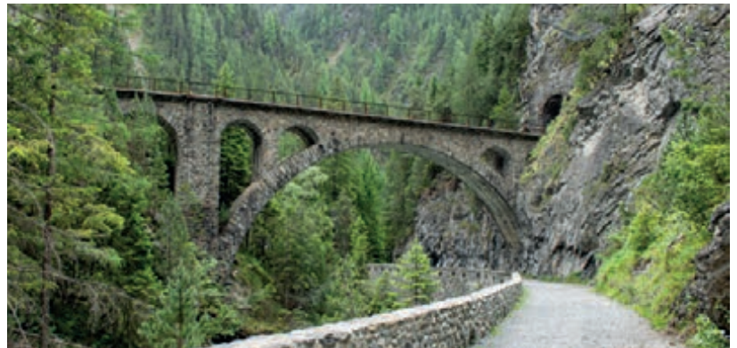
... wie im Original! Das Brombenzviadukt in Graubünden.
