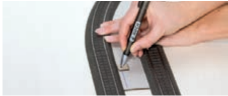
Gleise auf Bauteil auflegen und Kontur übertragen, ...
