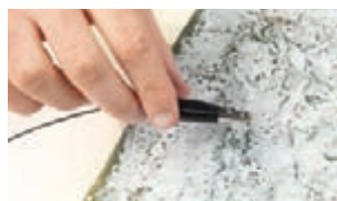
Die Krokodilklemme (Gegenpol) wird in der Nähe der zu begrasenden Fläche befestigt.
